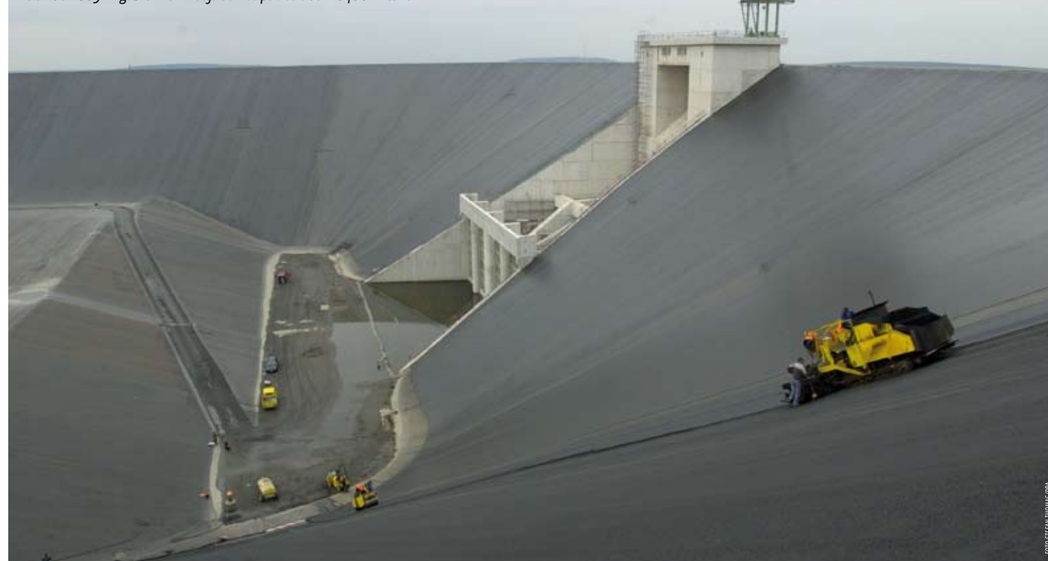
De pompaccumulatiecentrale Goldisthal, hier in aanbouw, is sinds 2003 in gebruik en heeft een capaciteit van 8480 MWh.
